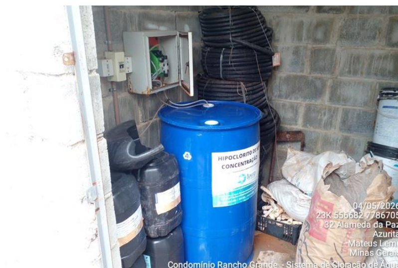
Figura 1 - Sistema de Cloração de Água
